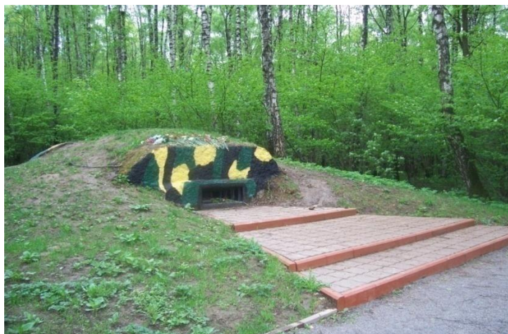
Памятник-дот в зоне отдыха «Тропарёво» на Юго-Западе Москвы.
