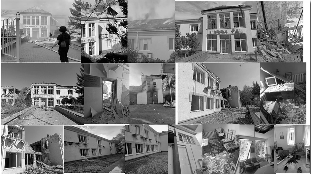
Рис. 2.30. Пошкодження будівель Закладу м. Костянтинівка Донецької області
